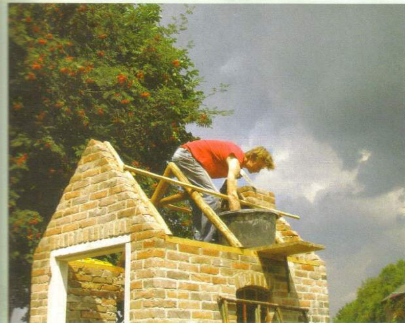
Onrustig metselen tussen de buien door...
